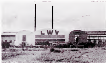
De Landswaatorvoorzieningsdienst distilleert uit zee-water drinkwater, dat gemineraliseerd is. Dit is de fabriek gelegen ongeveer in het midden van het eiland
